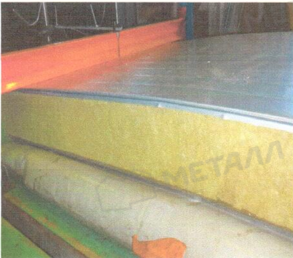
Разрушение образца №1 панели.
