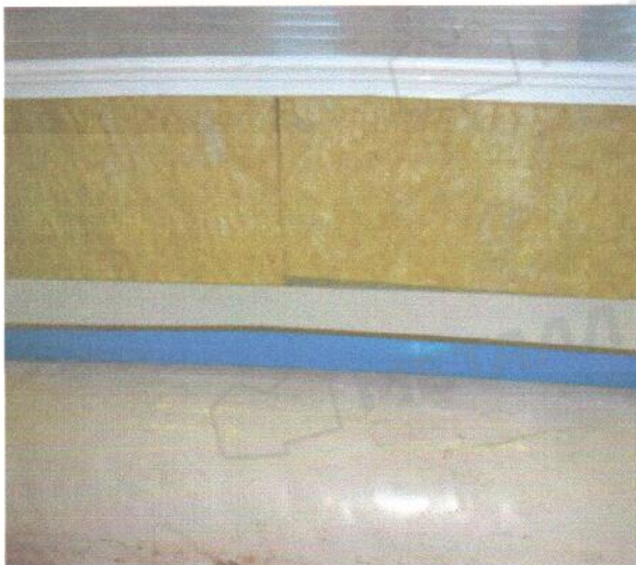
Разрушение образца №1 панели.
