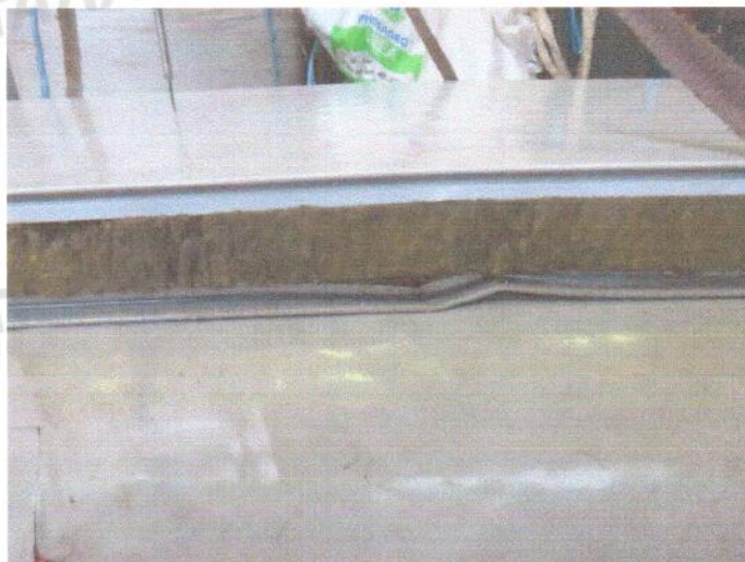
Разрушение образца №2 панели.
